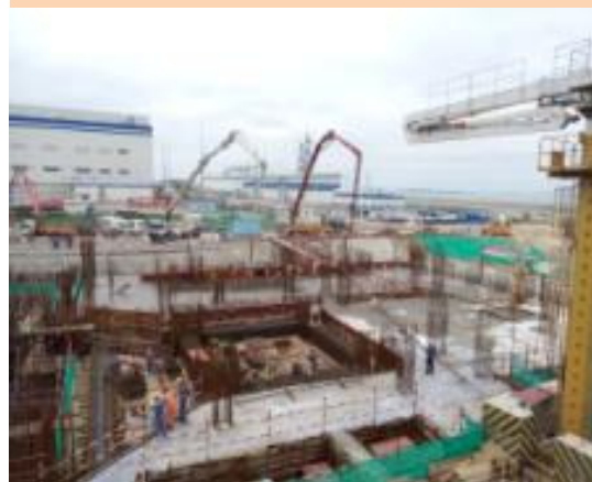
2016年10月11日5号机组汽机厂房第5块0m楼板浇筑完成
