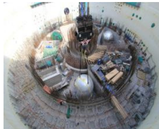
2017年1月25日6号机组三台 安注箱吊装就位
