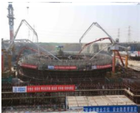
2015年5月7日5号机组核岛反应堆厂房浇筑第一罐混凝土
