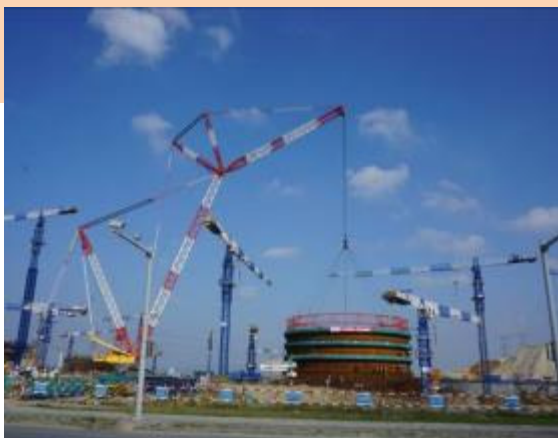
2016年9月22日6号机组反应堆厂房钢衬里模块三吊装就位
