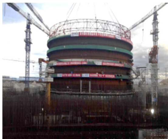
2015年11月22日5号机组反应堆厂房钢衬里模块三吊装
