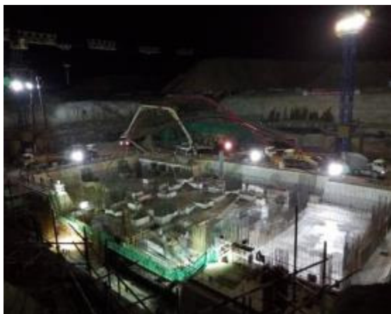
2016年8月26日6号机组常规岛第一块筏基混凝土浇筑完成
