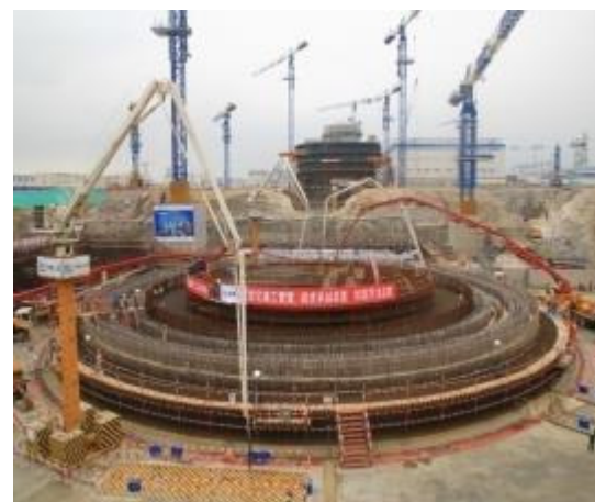
2015年12月22日6号机组核岛反应堆厂房浇筑第一罐混凝土
