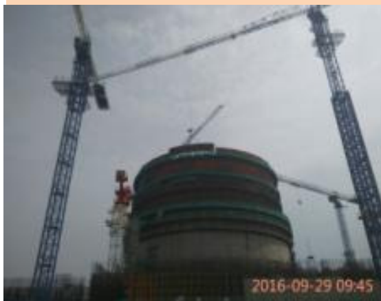
2016年9月29日5号机组反应堆厂房钢衬里第13段吊装就位
