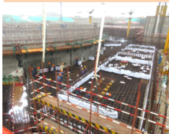
2016年4月13日6号机组安全厂房筏基四段混凝土浇筑
