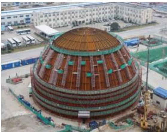
2017年1月1日5号机组穹顶 拼装完成
