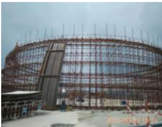
2016年8月12日5号机组反应堆厂房穹顶拼装开始
